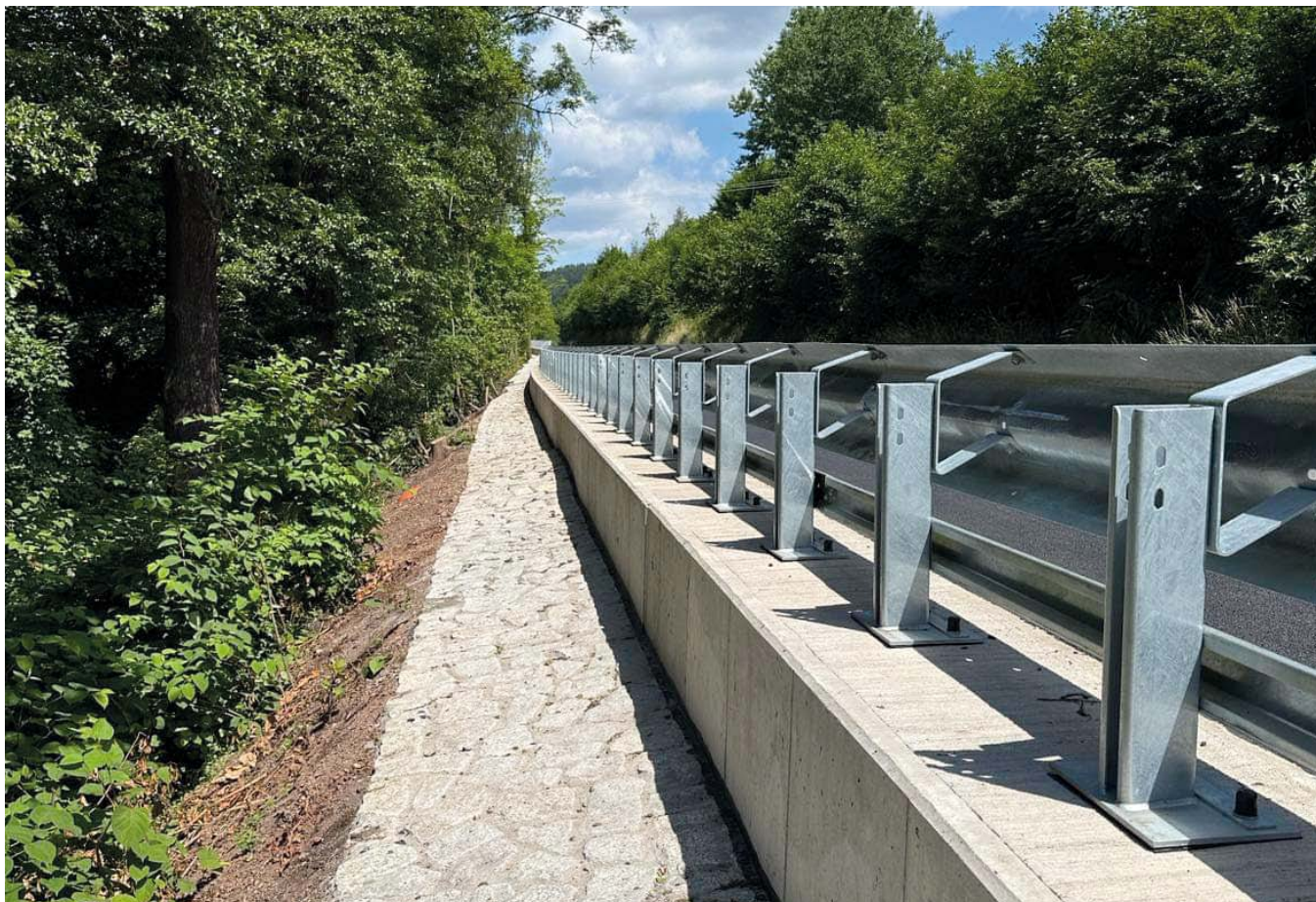
I/14 Suchovršice, sanace násypového tělesa
