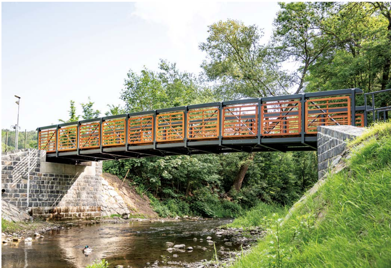
Lávka přes Jílovský potok v Děčíně
